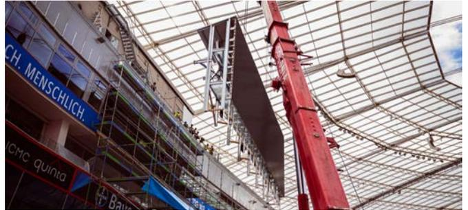
Nach der Planungsphase, inklusive Windkanalgutachten, wurde alles mitsamt dem nötigen Metallbau konstruiert und final vor Ort umgesetzt. Die beiden installierten Scoreboards verfügen bei 15,20 x 6,40 m über fast 100 m<sup>2</sup> pro Screen. Die Bildfläche wurde insgesamt um 50% erhöht. Der Pixelpitch wurde von 25 mm auf 6,67 mm verringert, was zu einer beachtlichen Gesamtauflösung von je 2.280 x 960 Bildpunkten führt.
